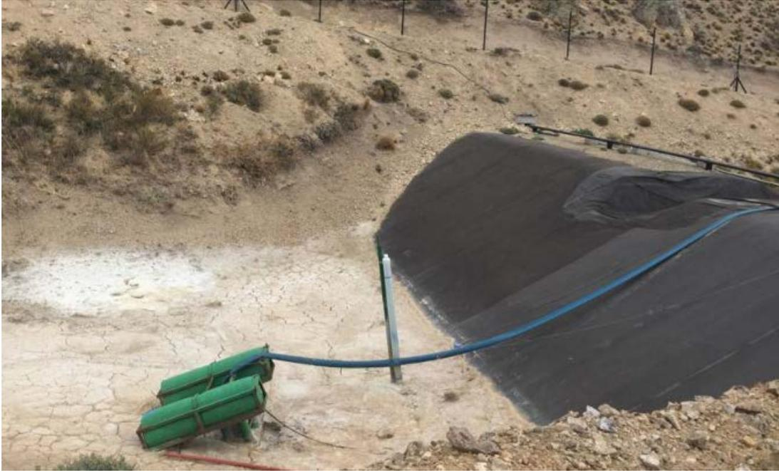
**Fotografía 23.5. Colección de filtraciones muro 3**
