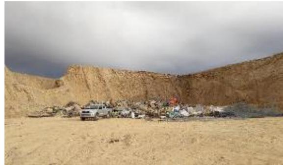
**Fotografía 19.2 y 19.3. Llenado y compactación de la Cava Main Vein con material inerte no peligroso.**
