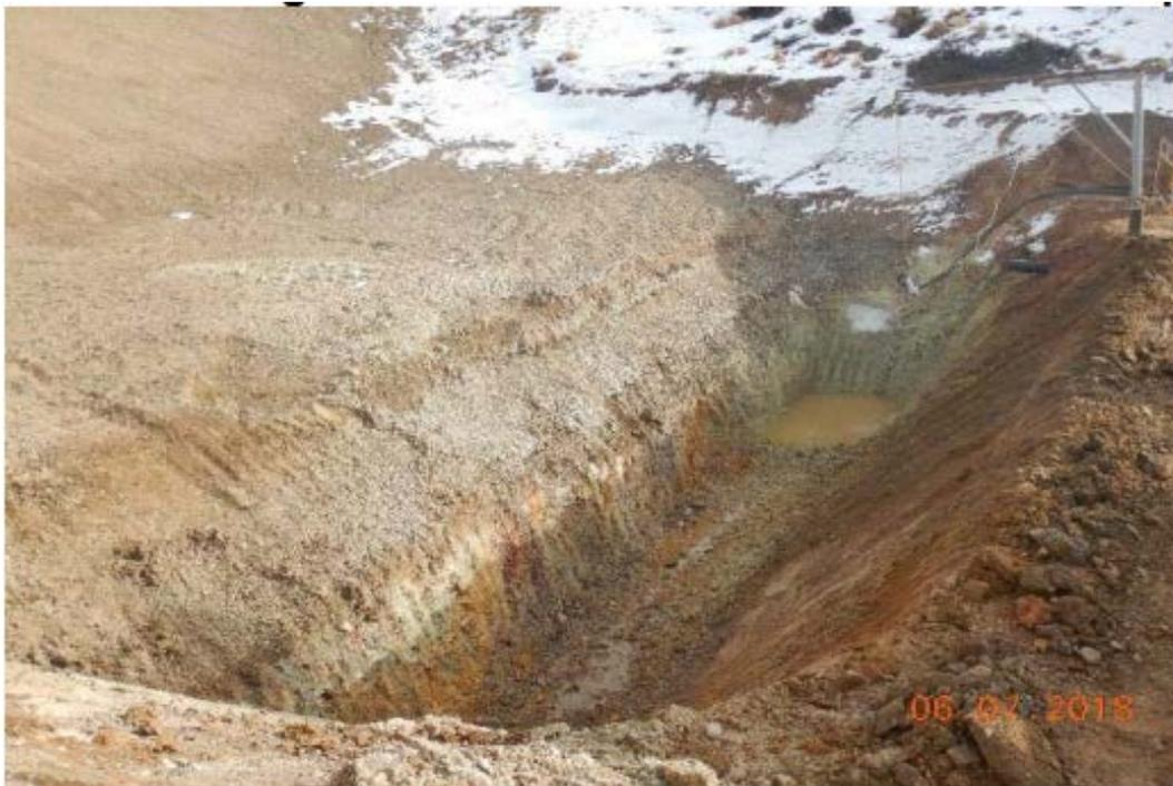
**Fotografía 23.3. Construcción trinchera de colección de Filtraciones**
