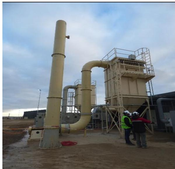
**Fotografía 43.2: Sistema de filtros mangas del Laboratorio**
