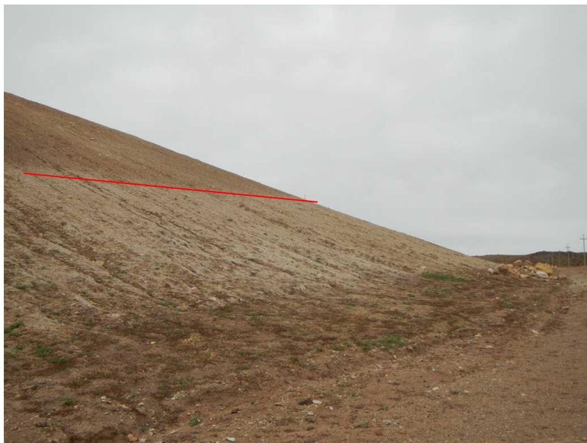
**Foto 39 Talud con orientación oeste en donde se observa el sector inferior que ha sido hidrosemebrado.**
